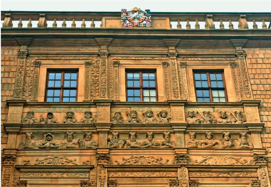
Trzecia kondygnacja, galeria antenatów oraz balustrada z herbem Jagiellonów (fot. Martyna Wiecha)
